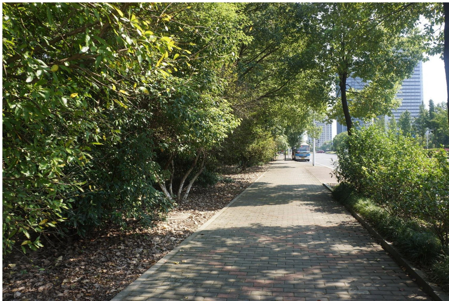
封堵的界面关系（改造前） 老旧破损的铺装（改造前）
