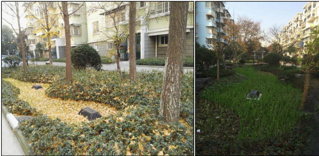
图 20 改造后的雨水花园
