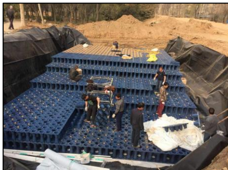
图 18 蓄水模块施工过程
