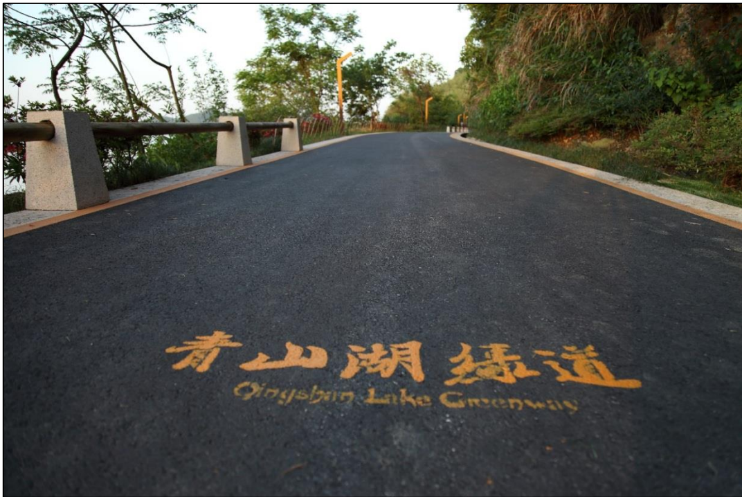
图 14 透水沥青道路实景图
