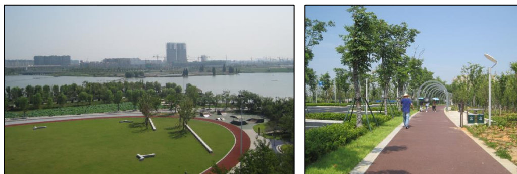
图 11 透水混凝土实景图
