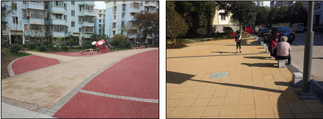
图 18 透水铺装局部图
