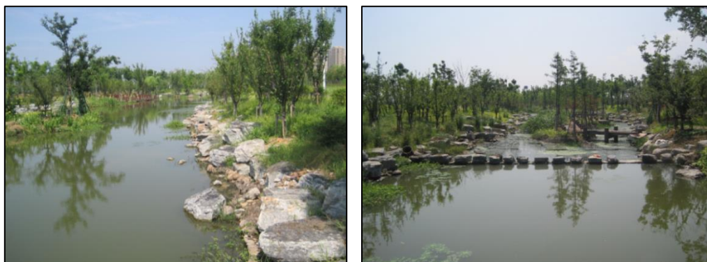
图8 花溪实景图2（生态护岸与阻水坝）
