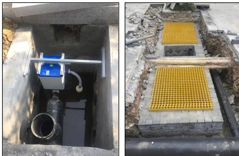
图 14 初期雨水弃流设施示意图
