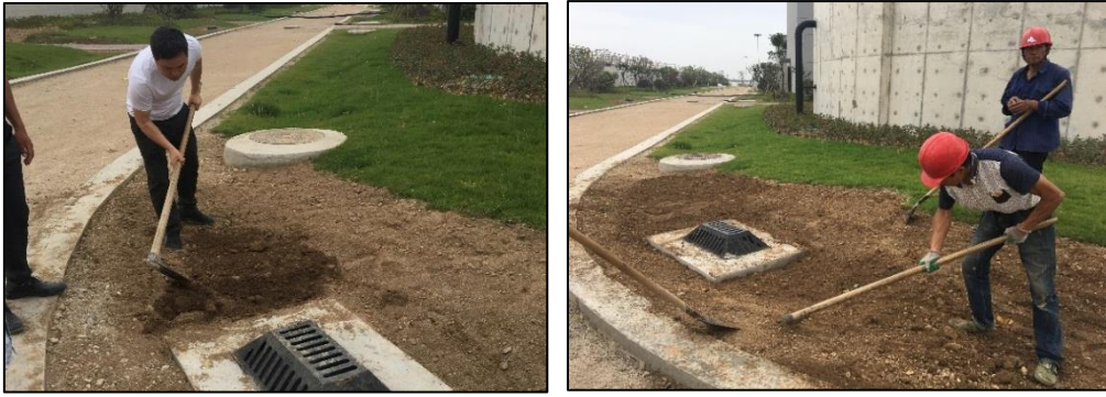
图 17 雨水花园施工过程图
