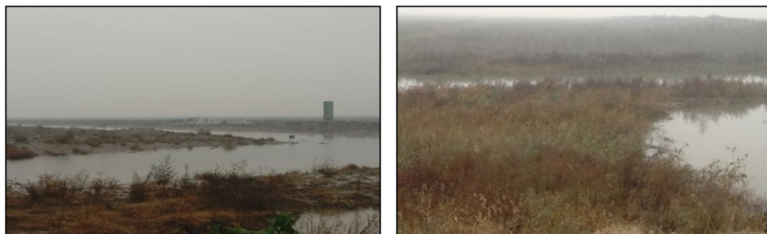
图5 海城大道建设现状场地图
