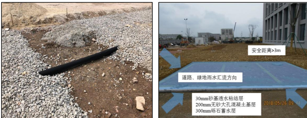
图 14 透水铺装停车场示意图
