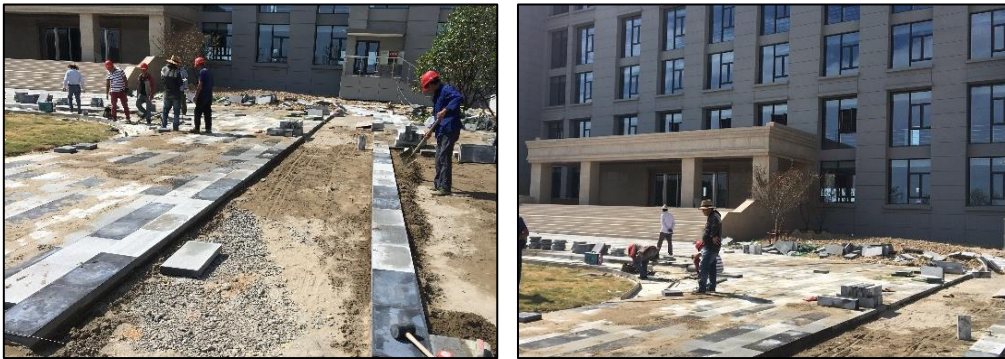
图 18 透水铺装施工过程图
