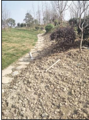
图 12 植草浅沟施工中
