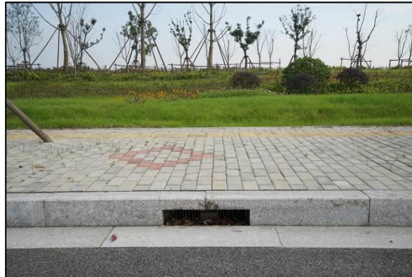
图 15 人行道排水沟完工后
