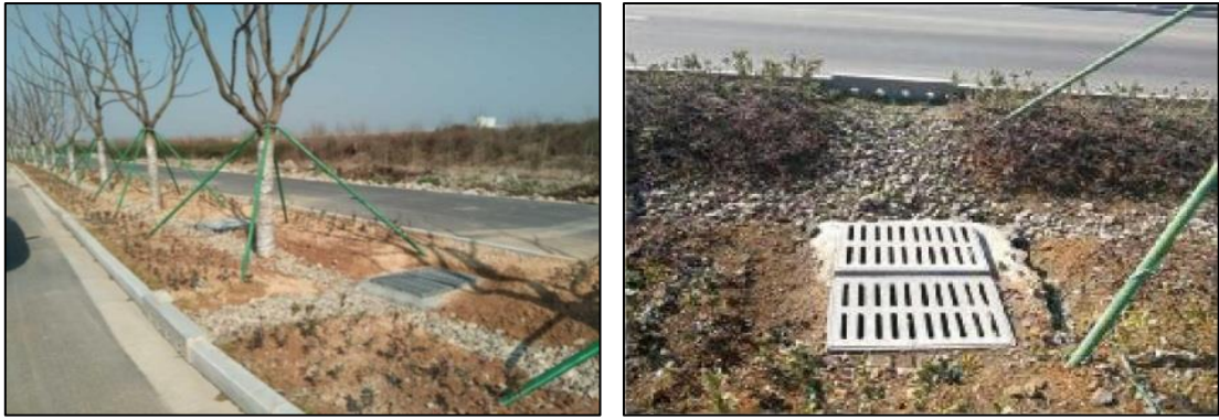
图 12 东部新区已实施下沉式绿地做法
