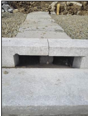
图 14 人行道排水沟施工中
