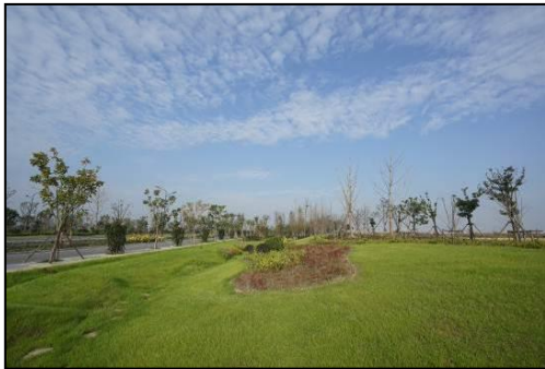
图 20 雨水花园完工后
