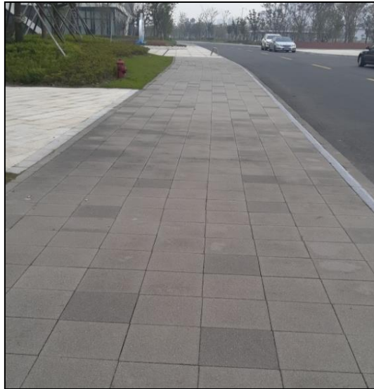
图 11 生态陶瓷透水砖铺装实景图
