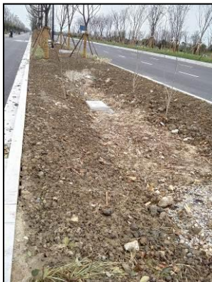
图 16 机非分隔带施工中
