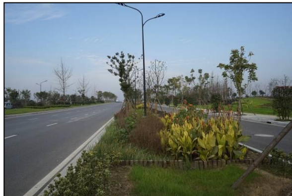
图 17 机非分隔带完工后
