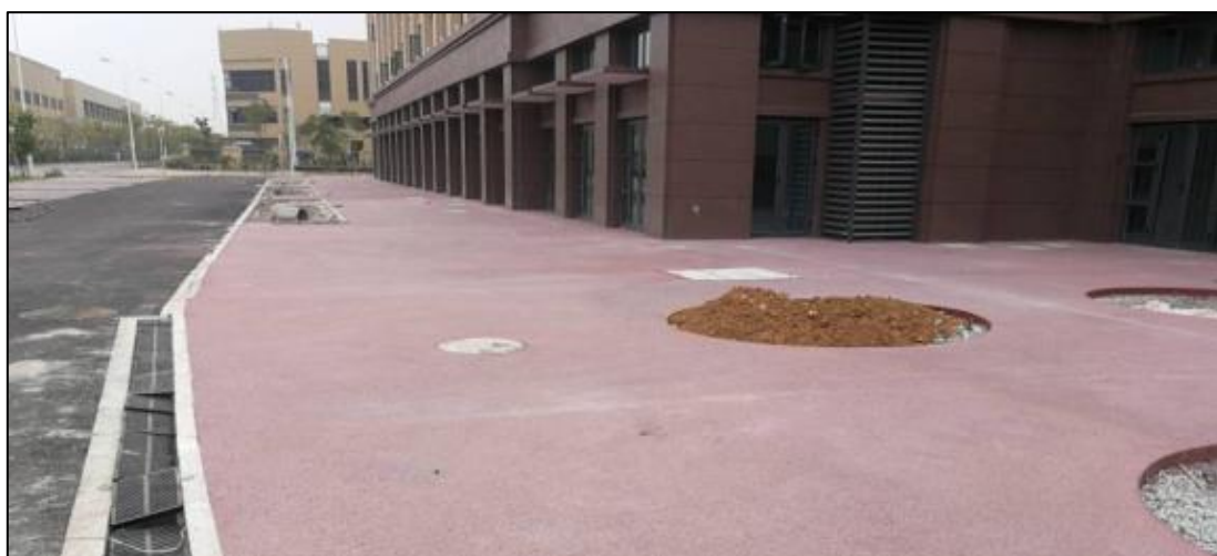
图 16 透水铺装施工
