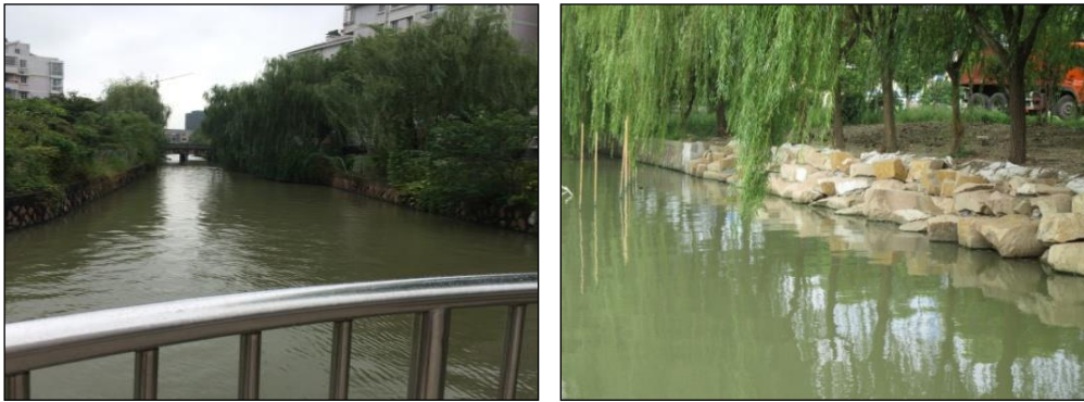
图 24 沿河驳岸改造前后
