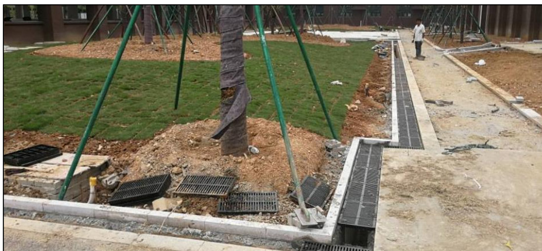
图 15 雨水收集沟施工图
